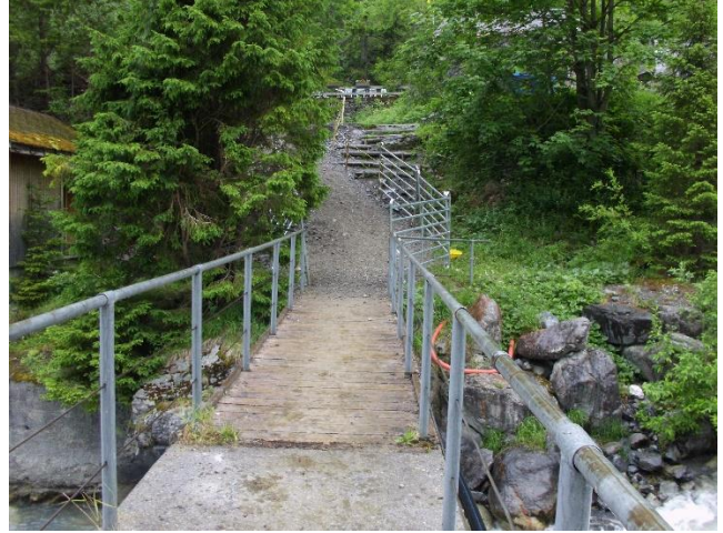
Auftrieb 24.6.2021: Sanierte Abstiegsstelle zur Brücke
