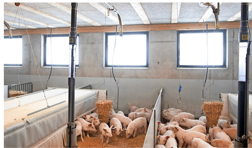
Durch eine poröse Decke sinkt neue Luft in den Stall ab, während verbrauchte Luft durch gesteuerte Klappen in den Abluftkanal gelangt. Fotos Monique Wittwer
